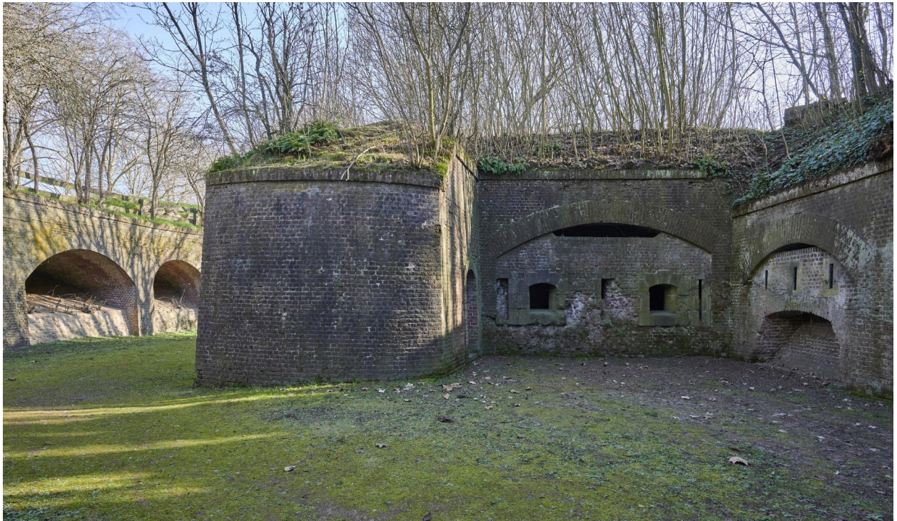
L'orillon gauche de la caponnière double, vers l'est. À droite la galerie de fusillade.
