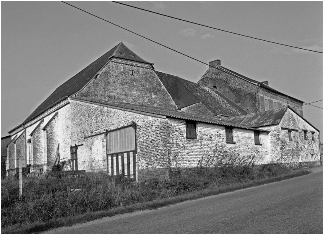
Vue de situation depuis la route, à l'ouest.
