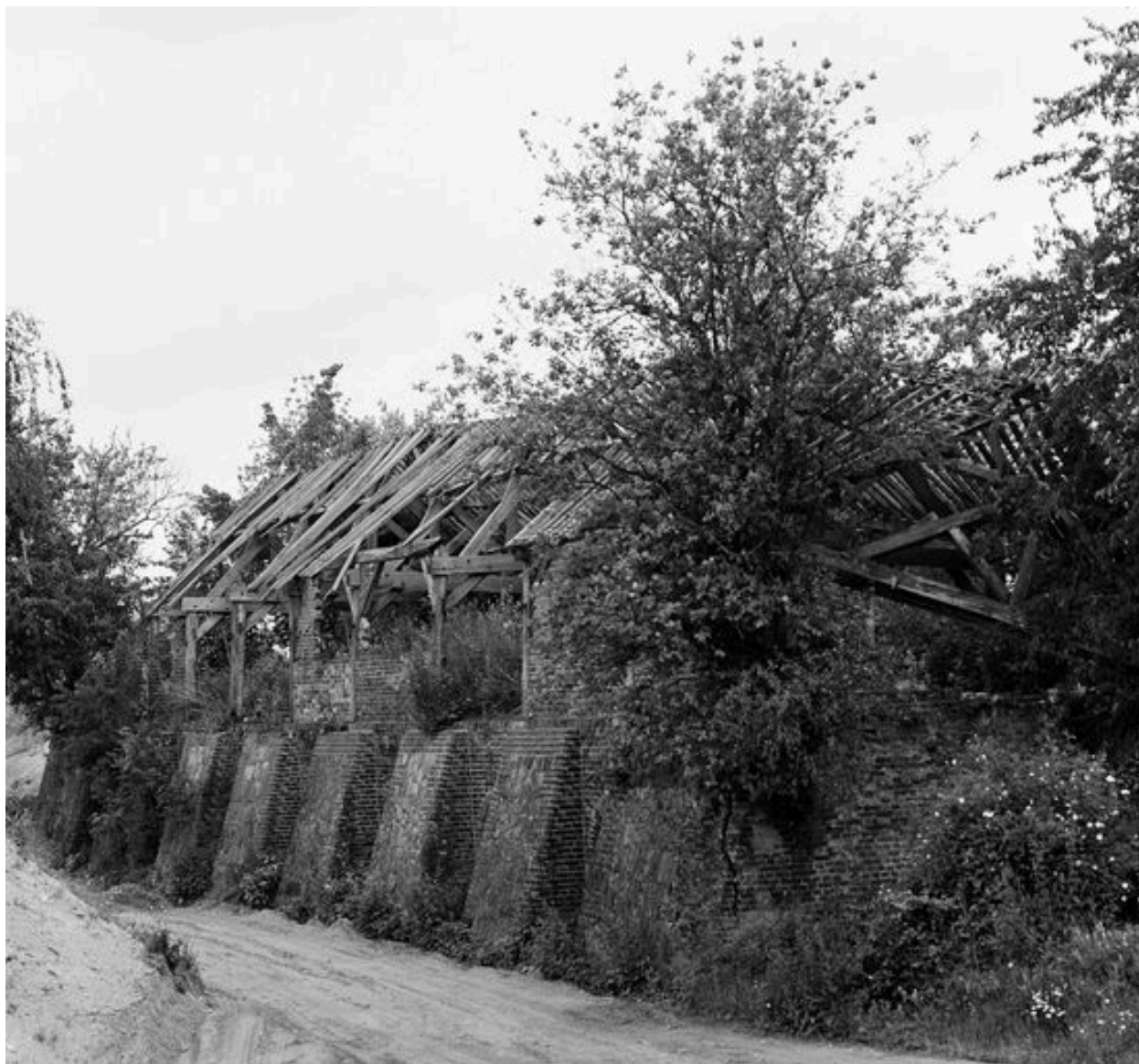
Four industriel de type Hoffmann, côté nord.
