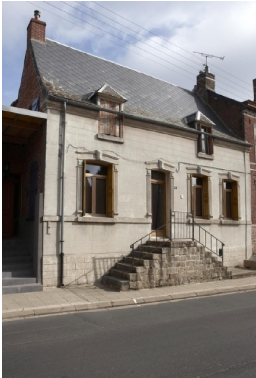
Vue générale de la maison située 350 rue du Centre.
