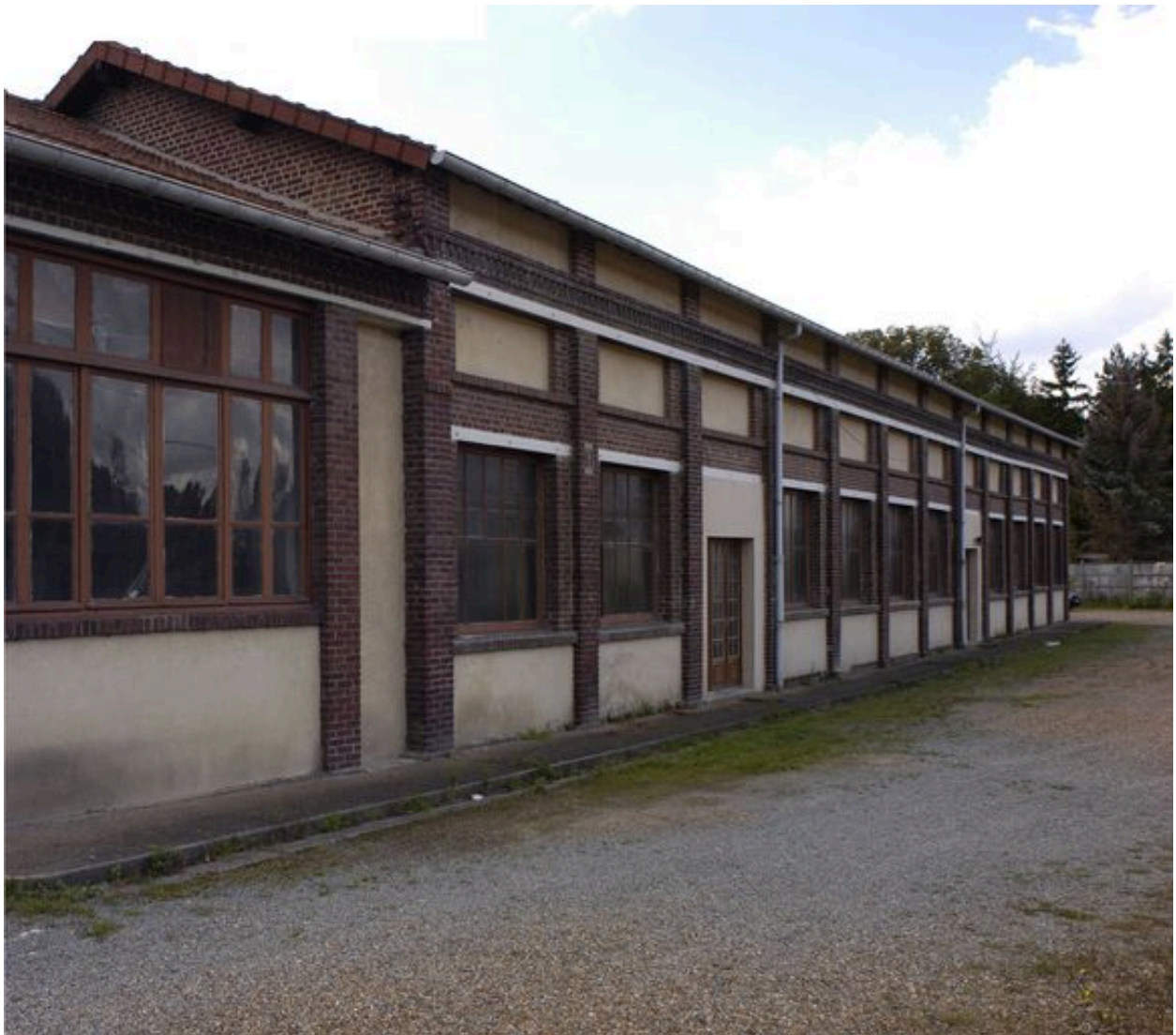
Vue générale des bureaux.
