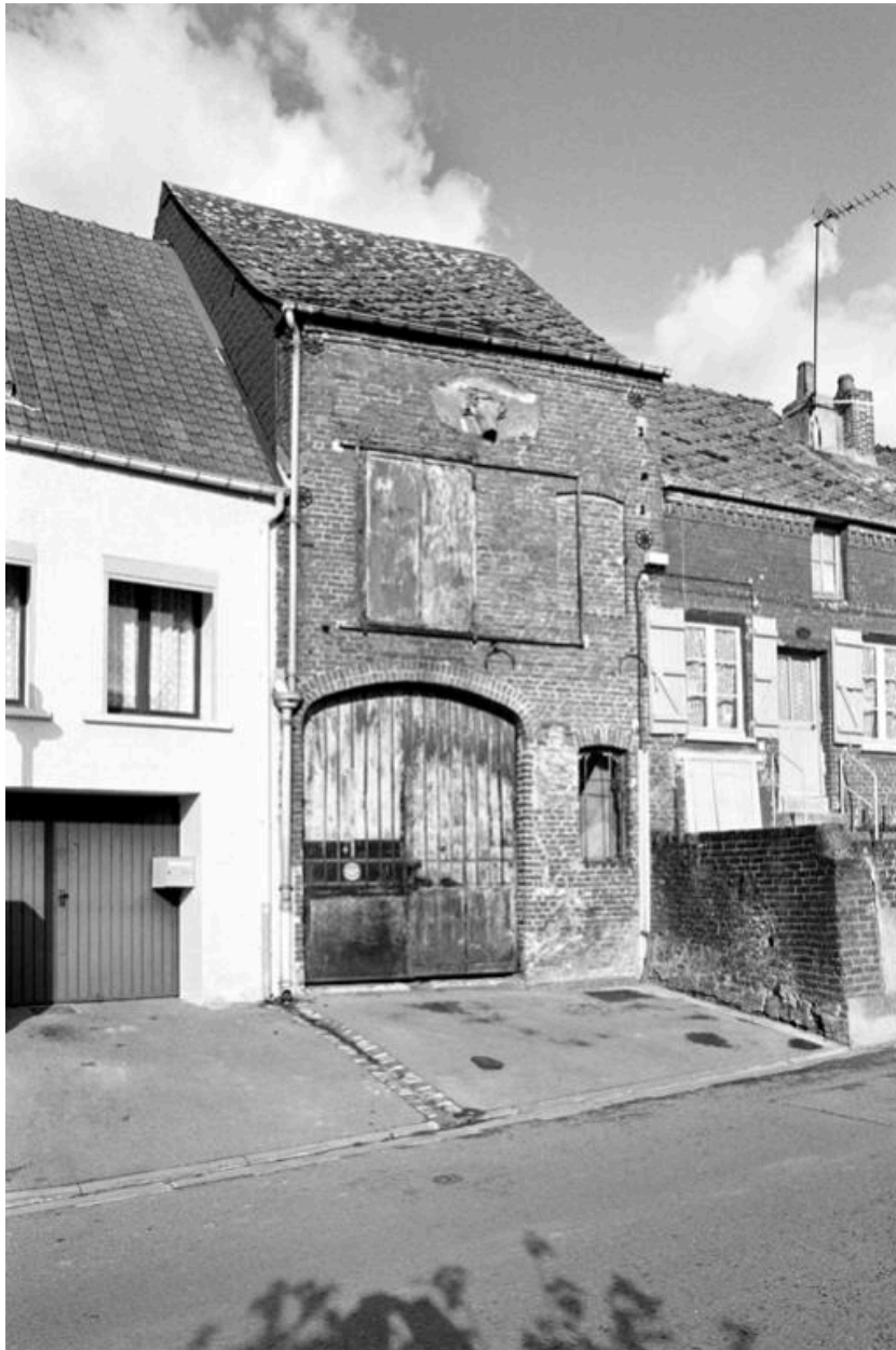
Vue de la façade sur rue.
