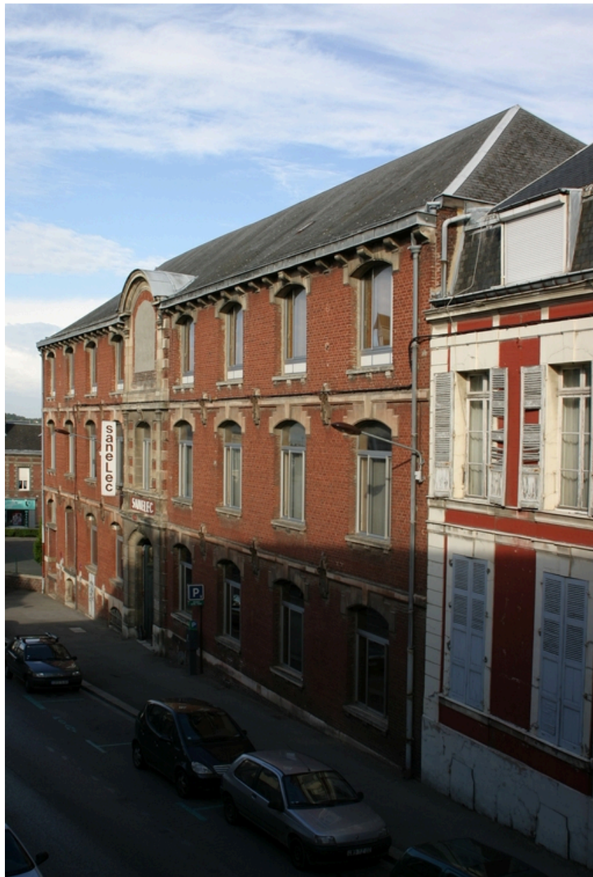
Façade antérieure de la maison de commerce.
