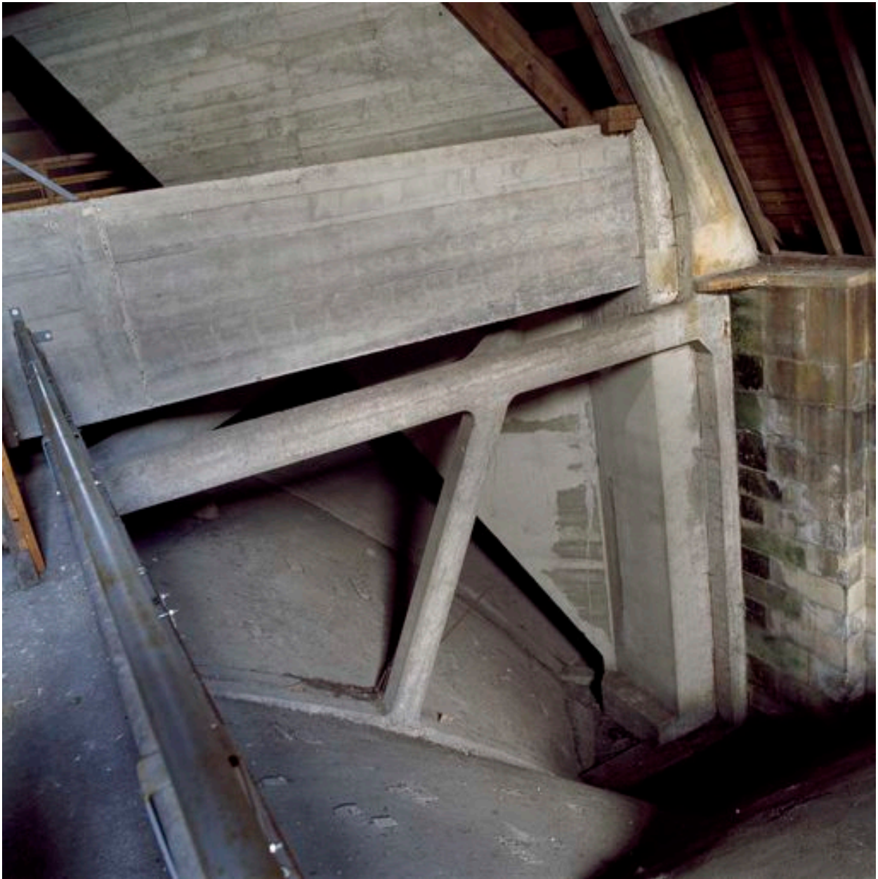
Détail de l'extrados des voûtes et de la charpente en béton.
