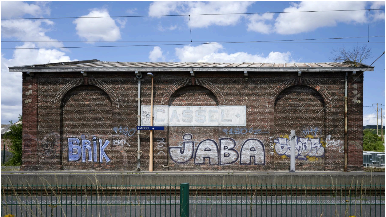
Façade sur voies.
