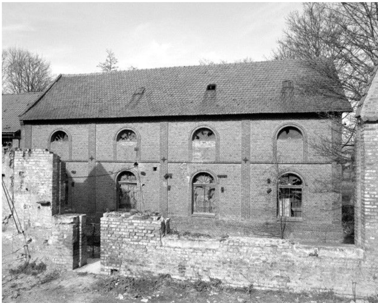
Ateliers de fabrication, flanc est.
