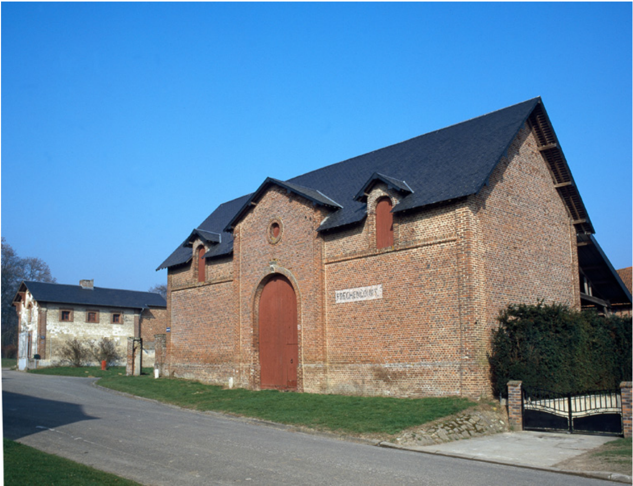
Grange dépendant du château, le long de la Grande-Rue, vue depuis le sud-ouest.
