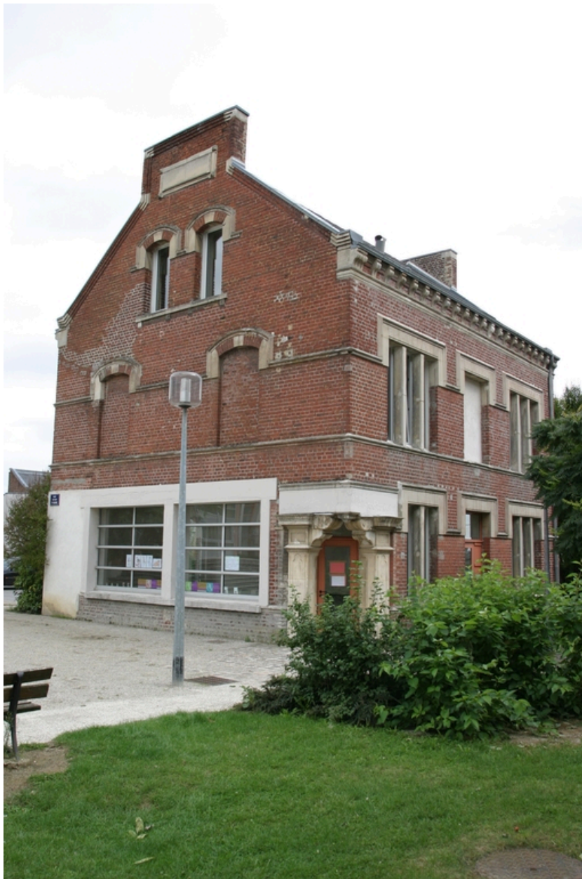
Les anciens bureaux vus du nord-ouest.
