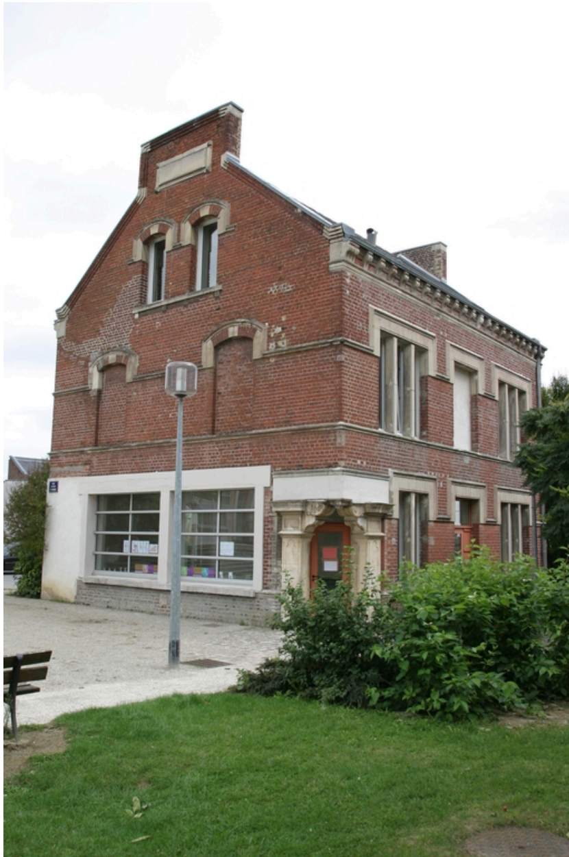
Les anciens bureaux vus du nord-ouest.
