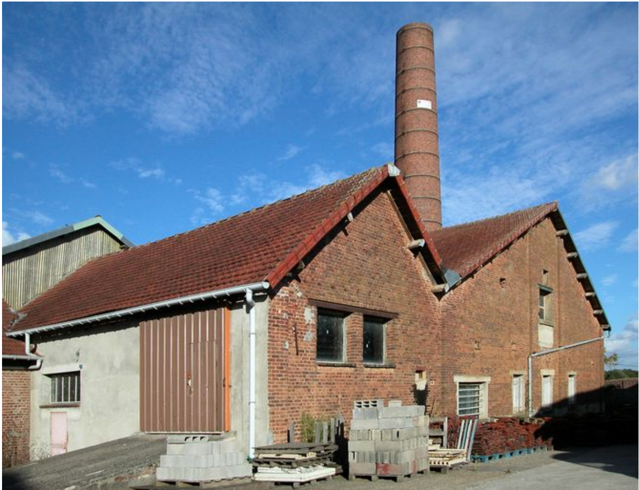
La salle des machines avec la cheminée à l'arrière.
