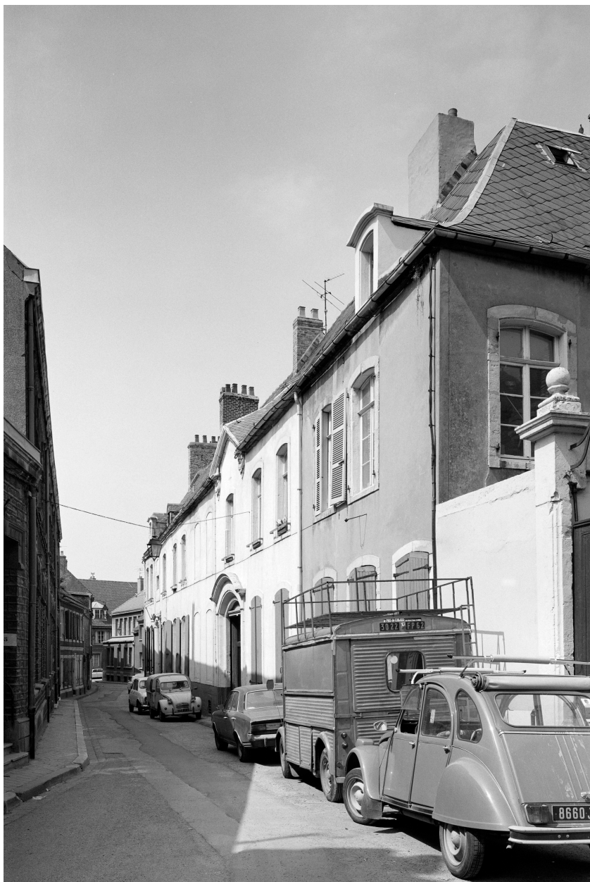
Vue générale sur voie.
