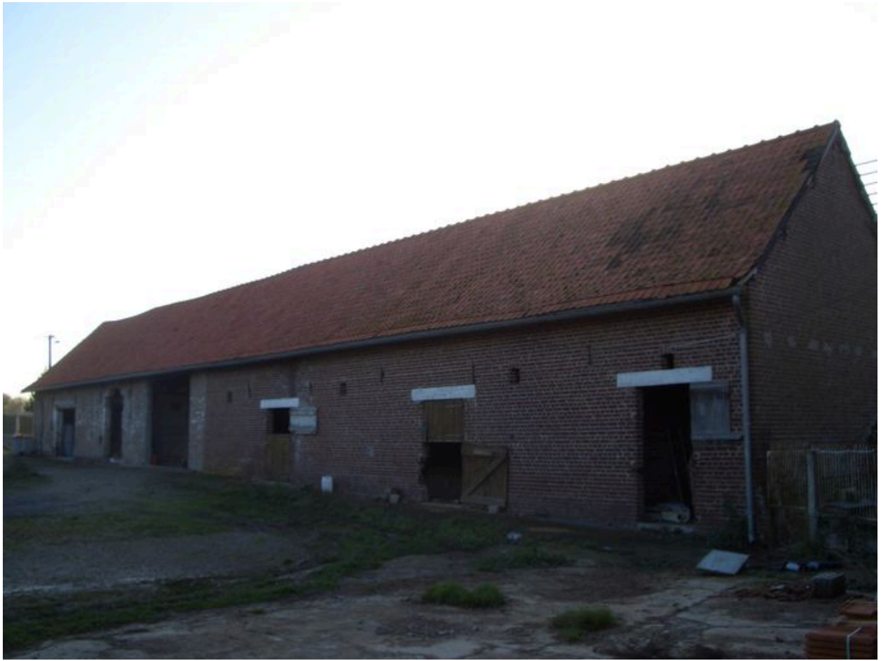
Vue des étables et écuries depuis la cour.
