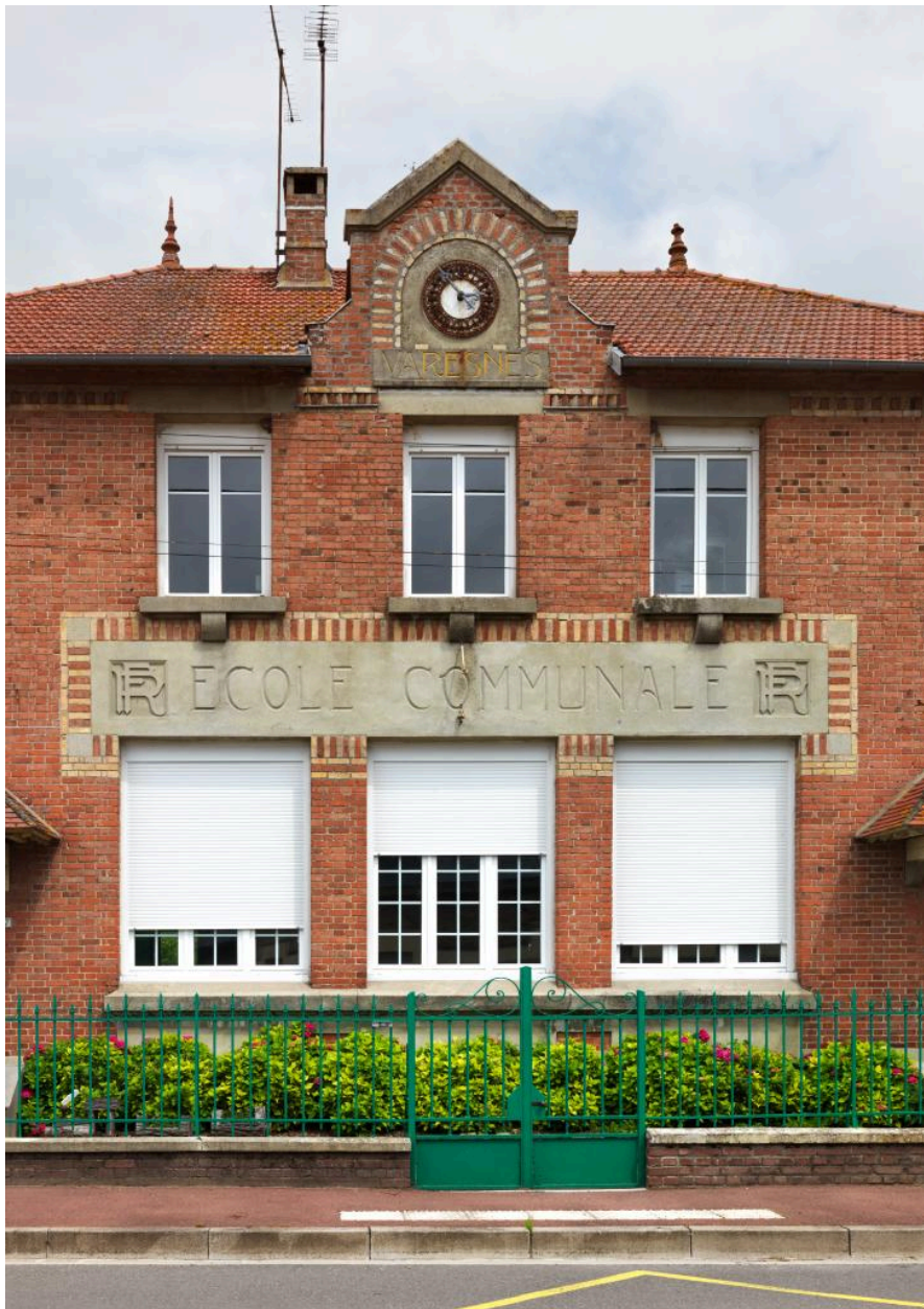
Vue des travées centrales.
