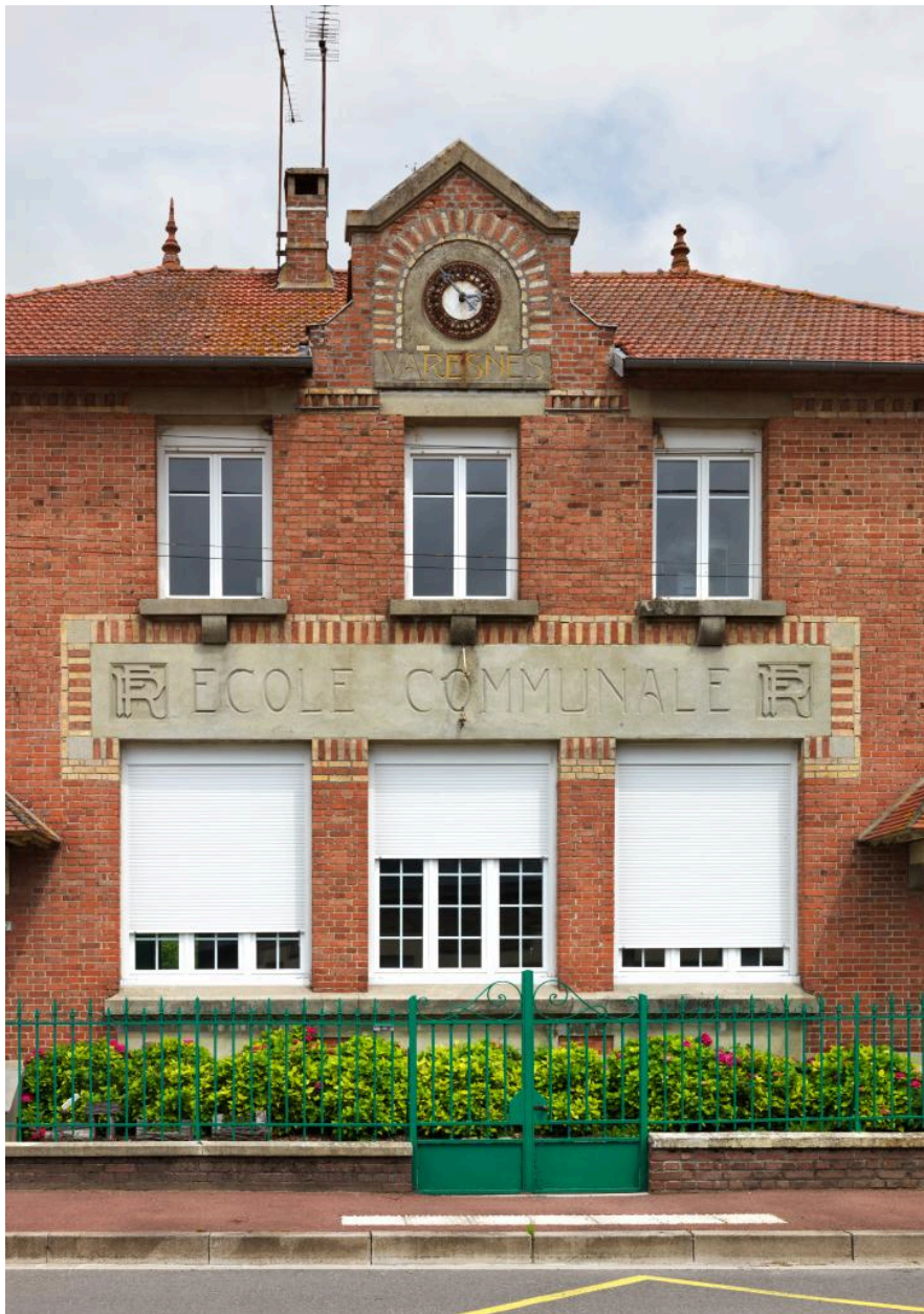
Vue des travées centrales.
