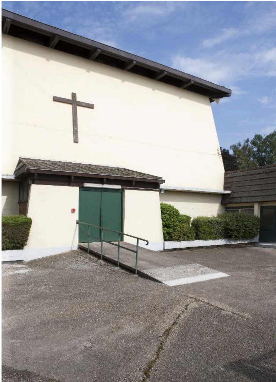
Élévation antérieure de l'église.
