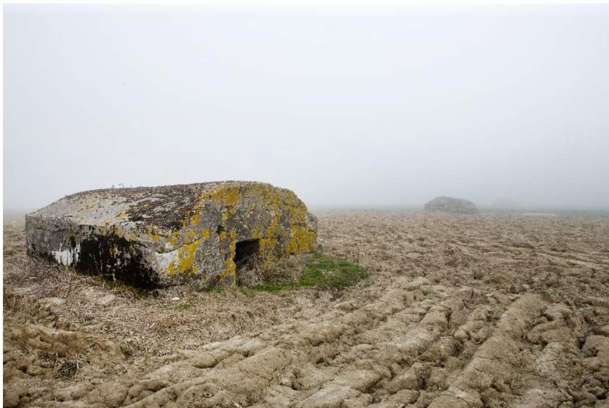
Vue de trois-quarts vers le nord-est
