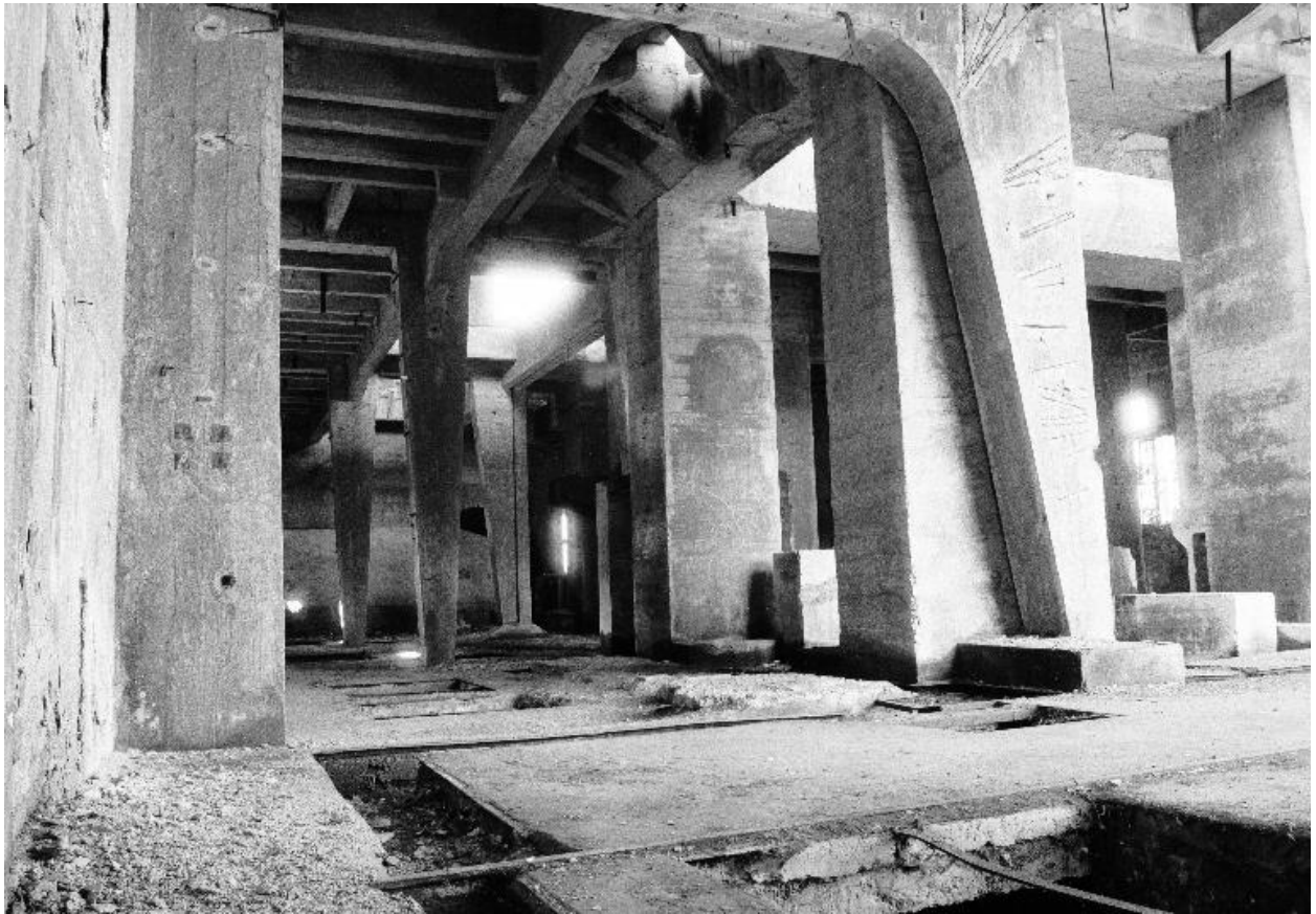
Atelier de fabrication, intérieur, vue partielle.
