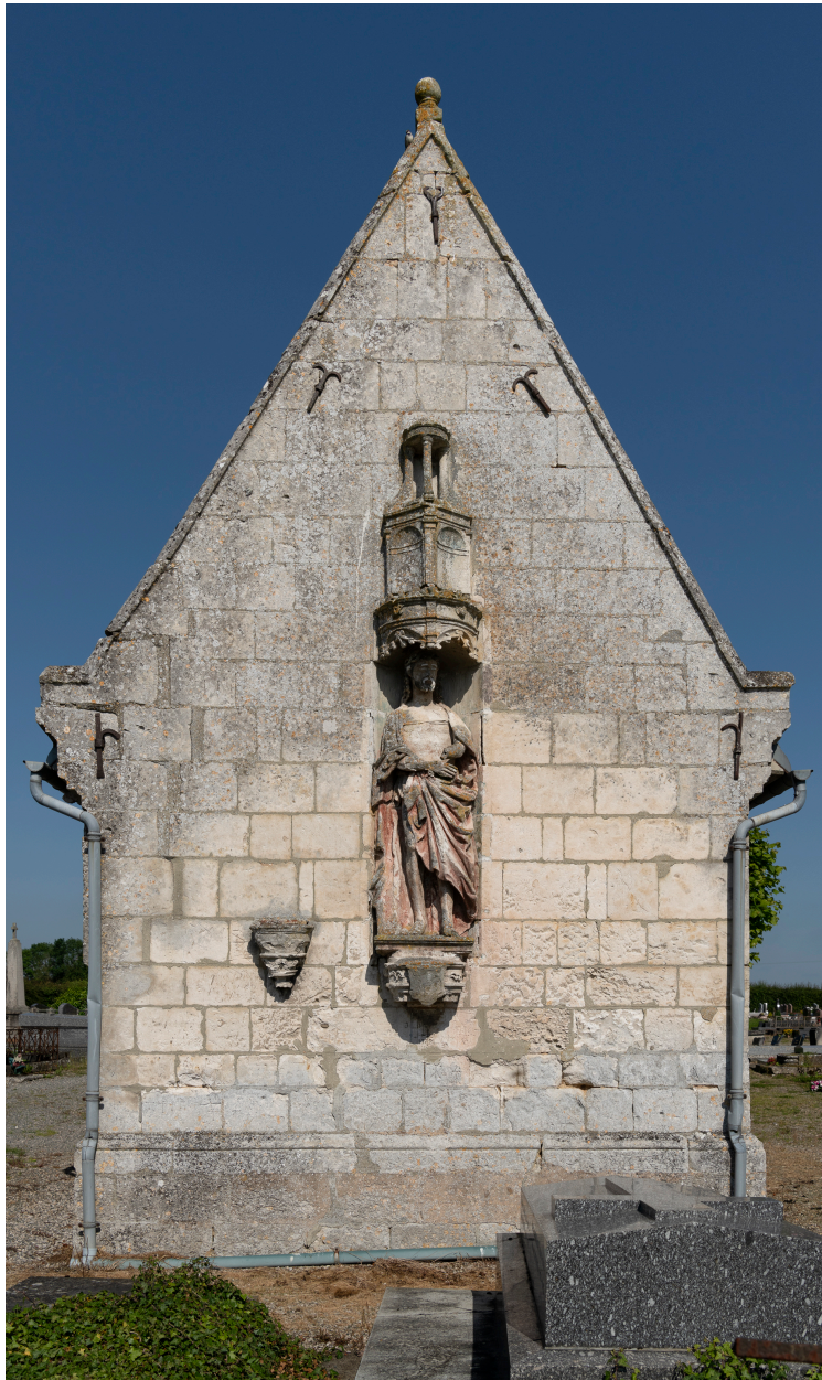
Élévation orientale de la chapelle avec statue (saint Roch?) dans une niche.
