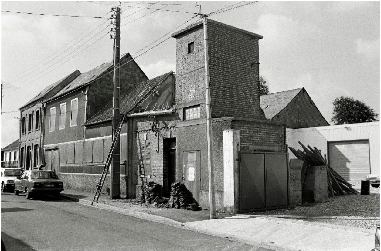
Vue des bâtiments (détruits), qui bordaient la rue en 1990.
