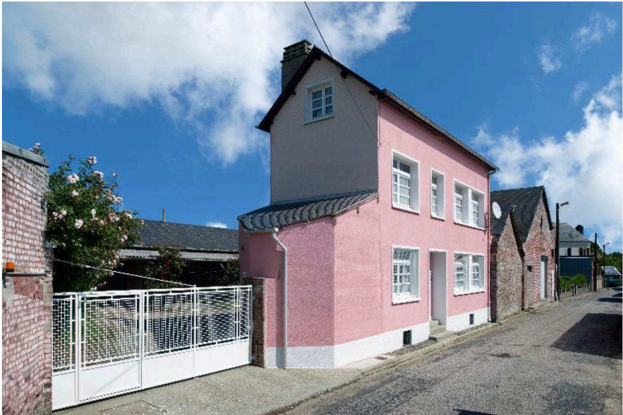
Vue des bureaux de l'ancienne usine Priez depuis la rue du 1er mai.
