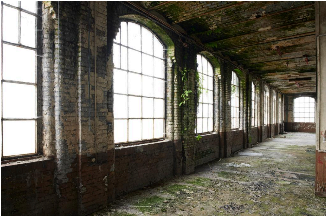
Vue intérieure de la filature. Vue longitudinale du deuxième étage. Détail des baies.
