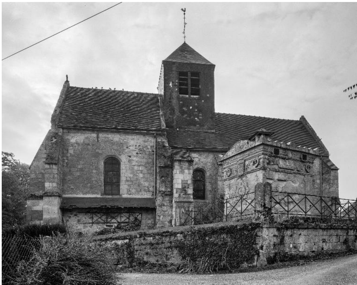
Vue nord de l'église et du tombeau du général Charpentier.
