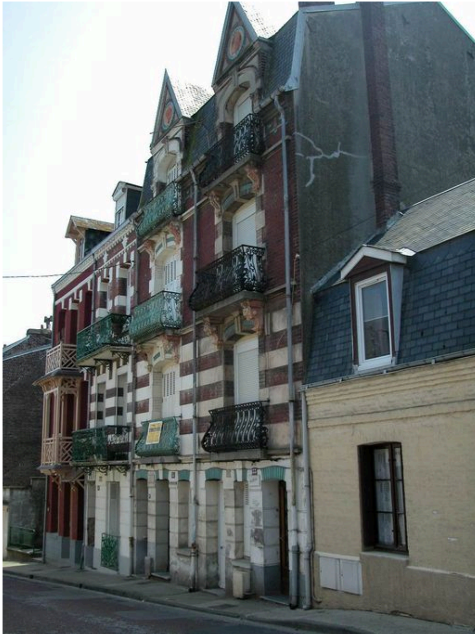
Ensemble de maisons à plusieurs entrées au rez-de-chaussée (27 à 33 rue Pasteur), dont Villa Pierre Lefort au n°29.
