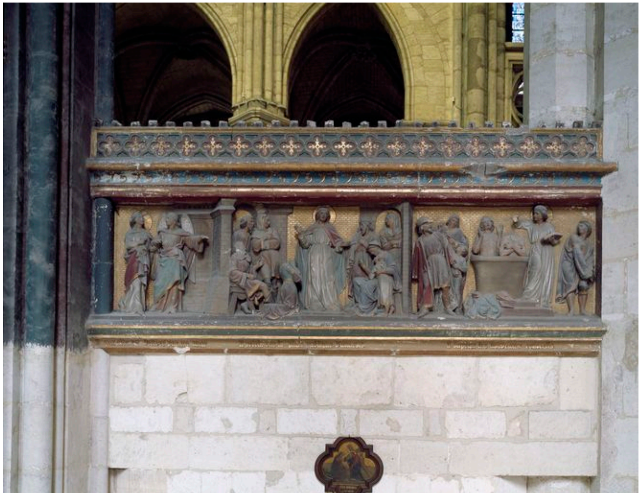
Vue de la quatrième travée sud.
