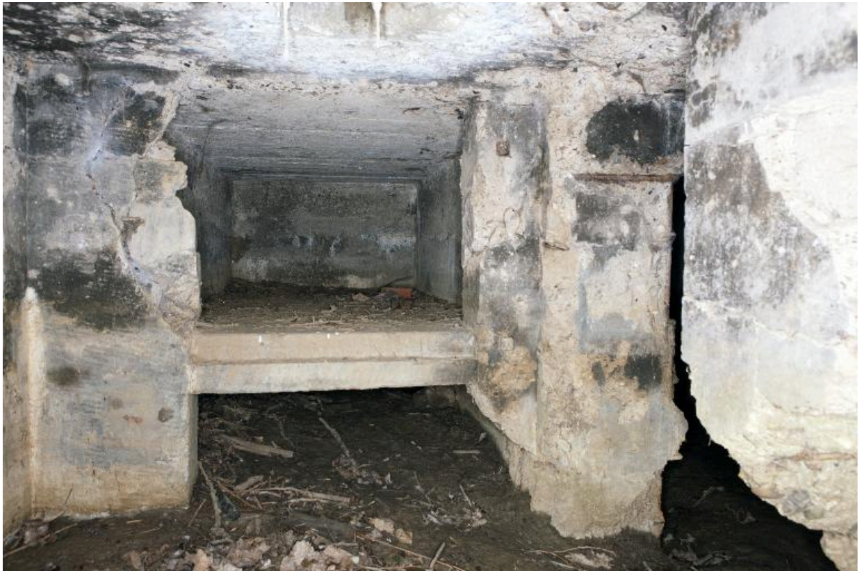
Vue interieure. Resserre à mitrailleuse
