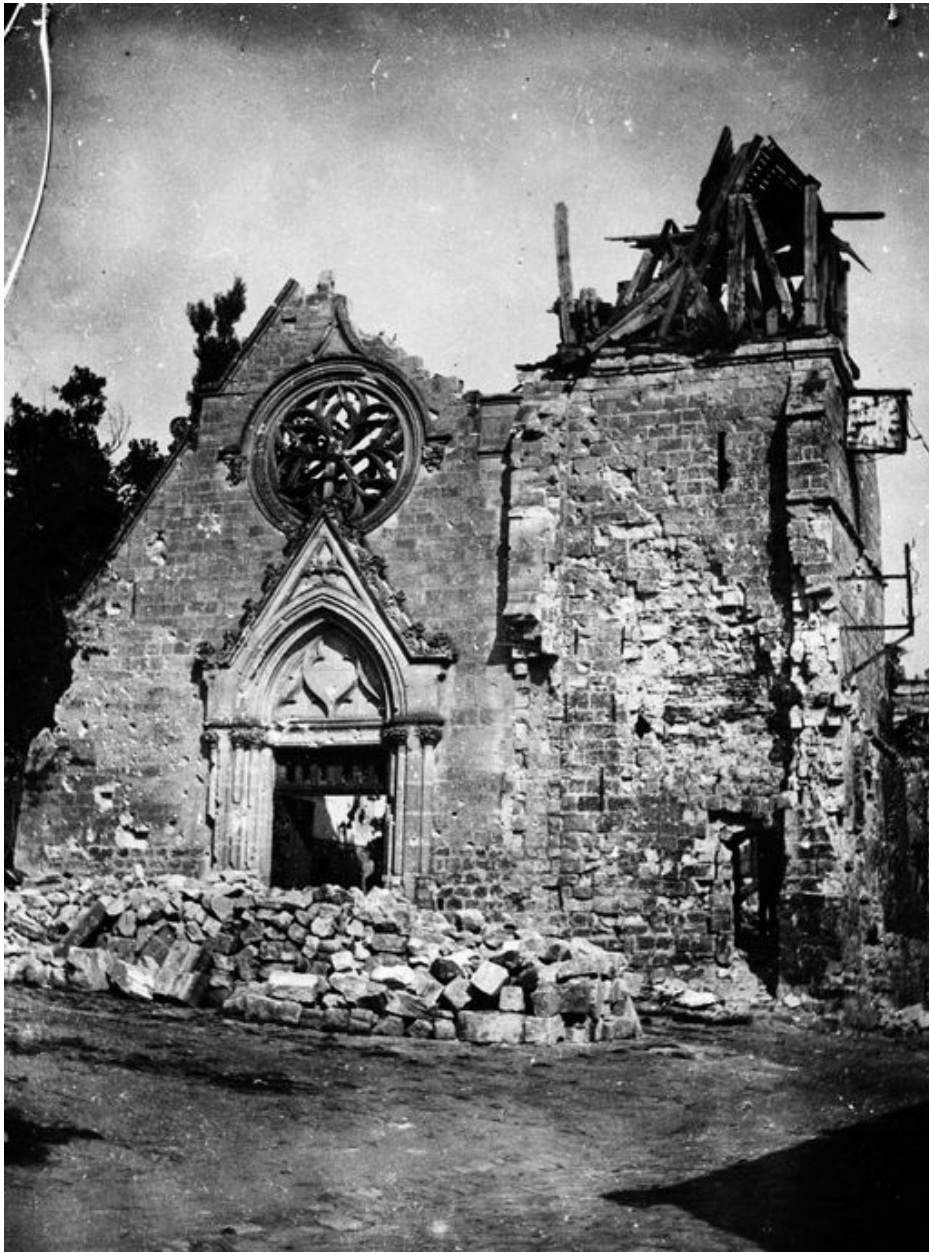
Façade occidentale, vers 1918 (AP).
