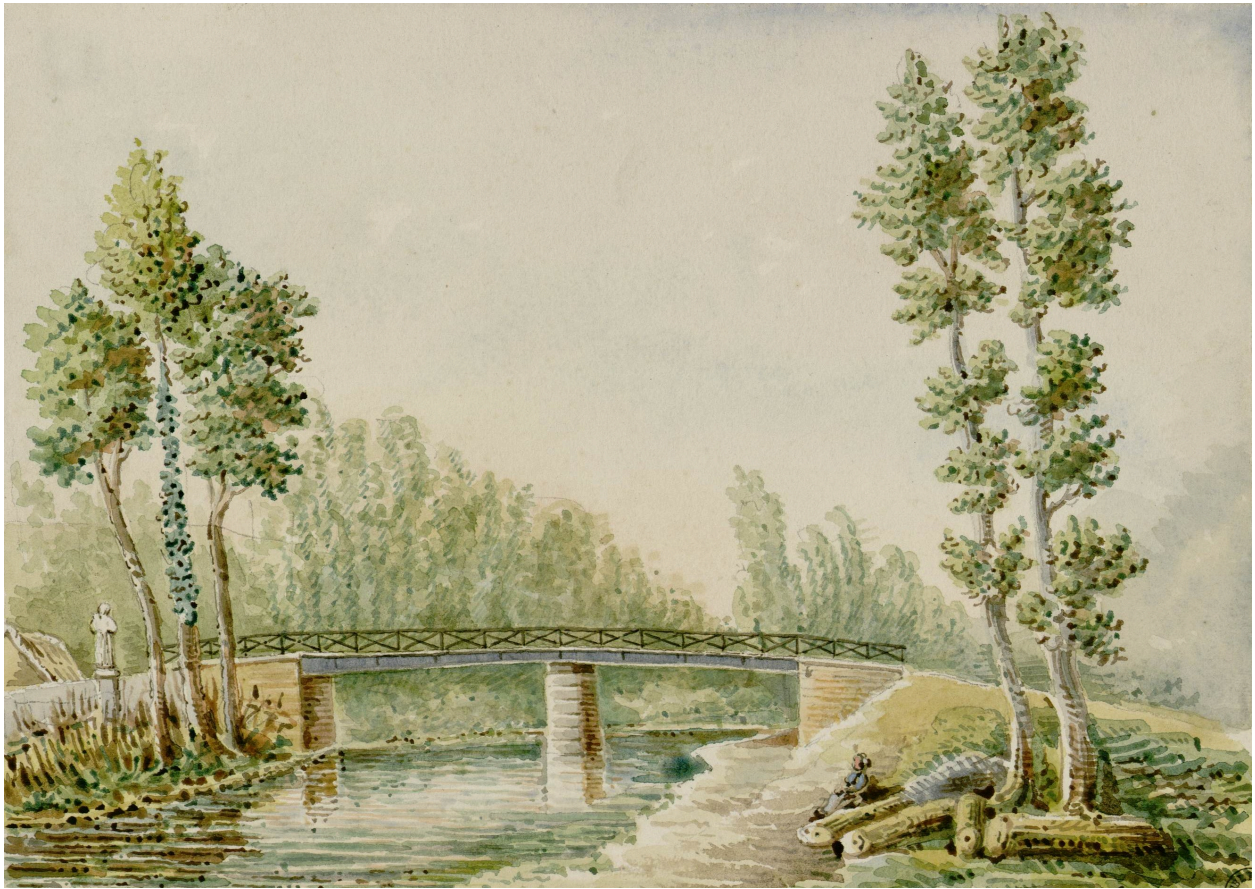
Nouveau pont sur la Somme à Épagne, par Oswald Macqueron, d'après nature, 29 avril 1887 (Archives et Bibliothèque patrimoniale d'Abbeville ; Ab.M38).
