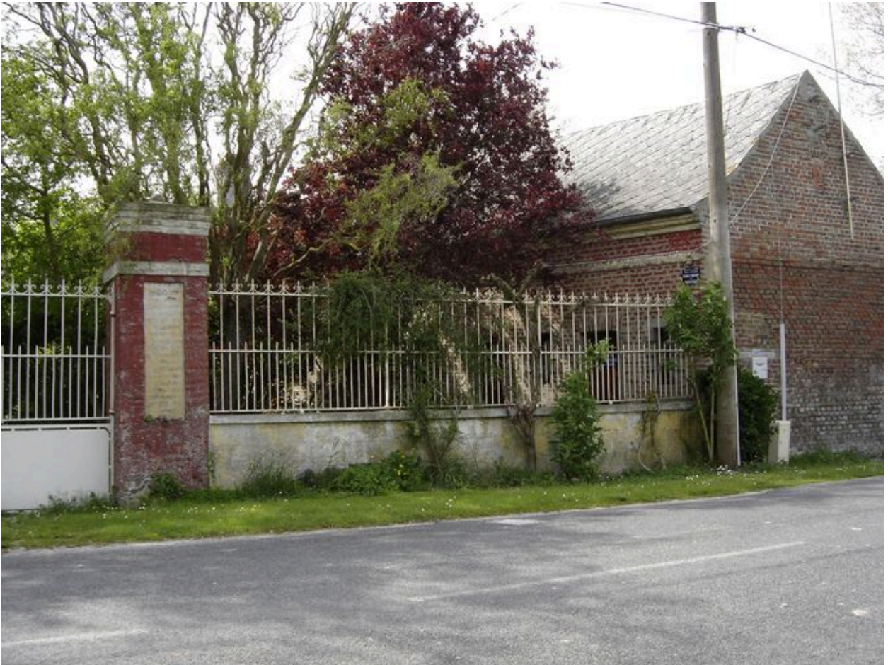
Vue sur le pignon du bâtiment nord.
