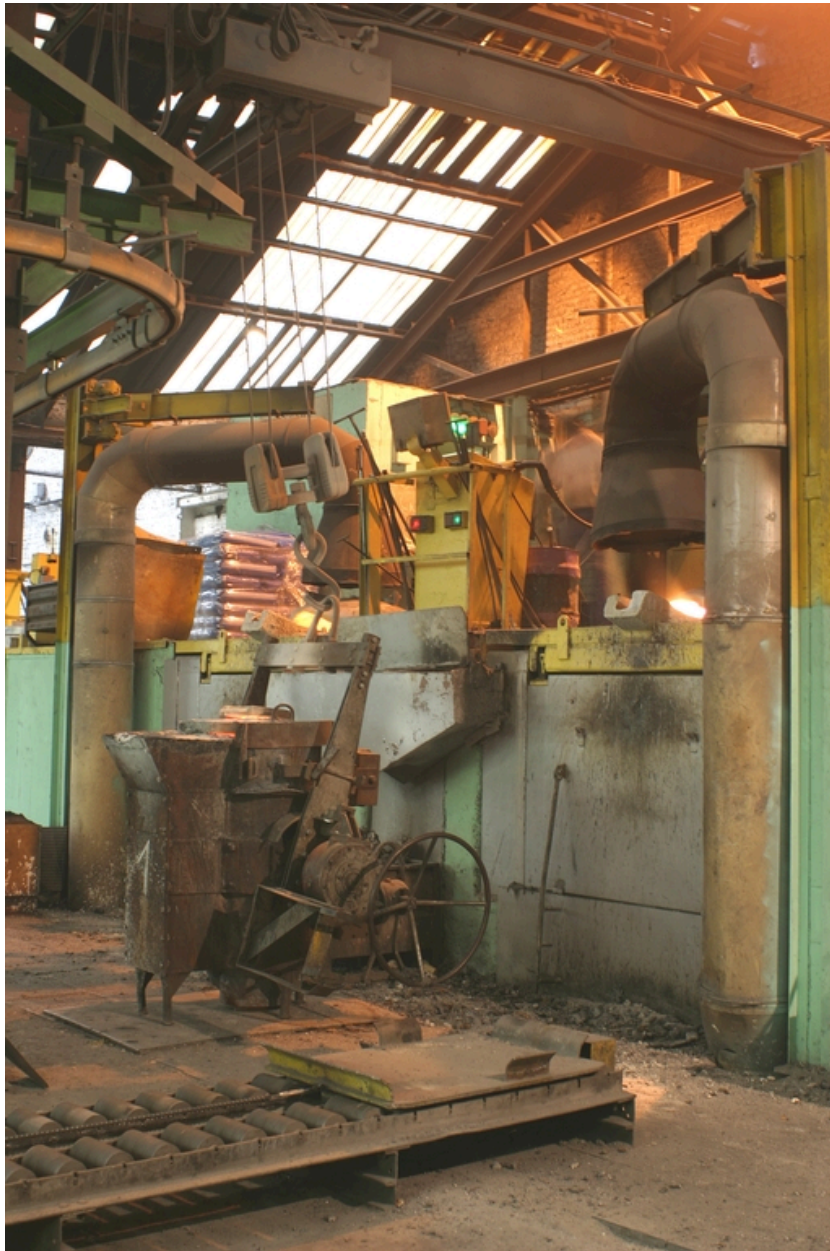
Poche de coulée en attente au pied d'un four.
