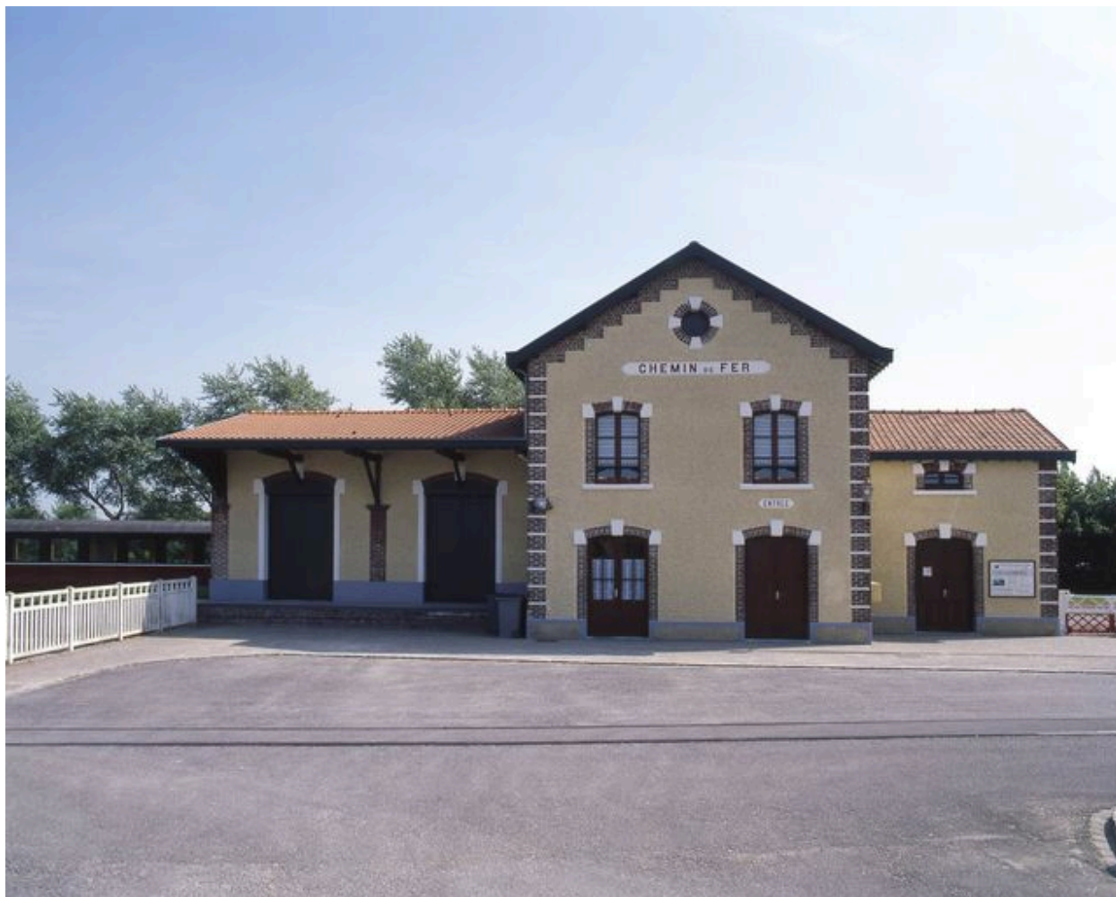
La gare du Crotoy, vue d'ensemble.
