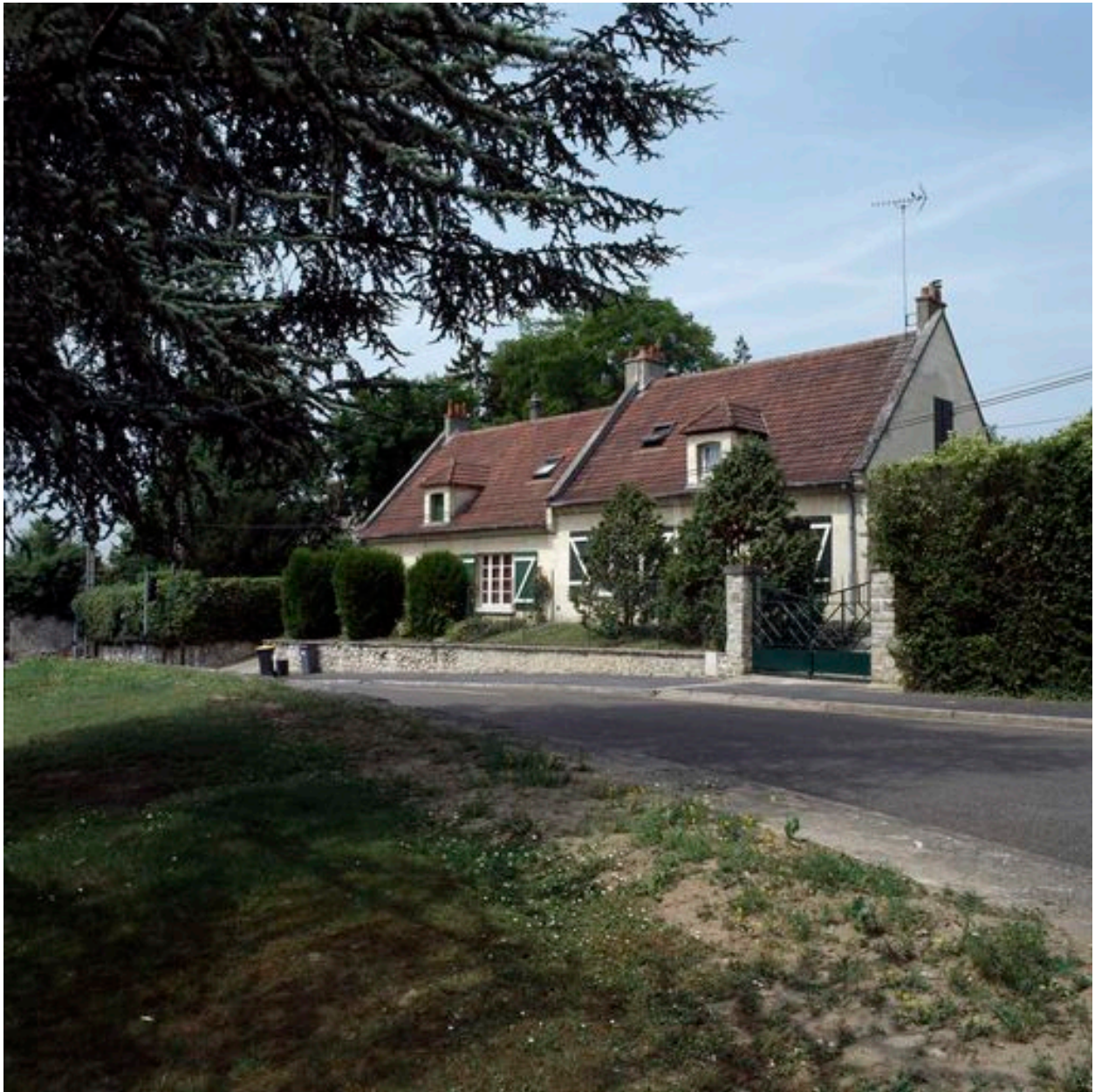
Deux maisons jumelées de la cité du Bas-Mettemont.
