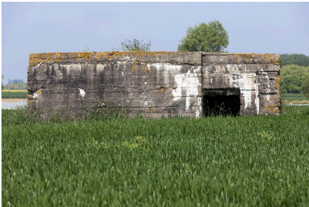
Entrée sur l'élévation nord-est
