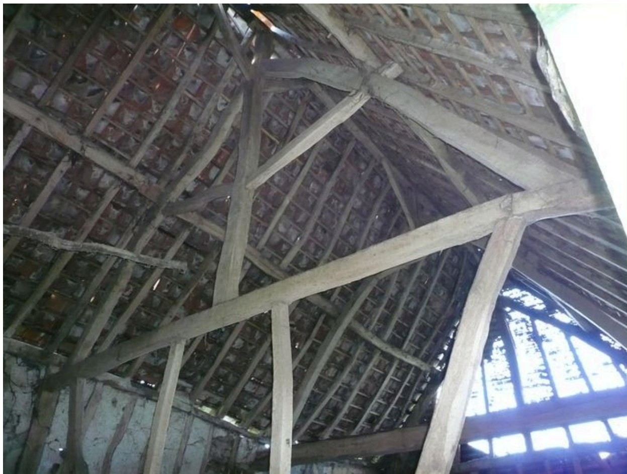
Vue d'une autre ferme de la charpente.
