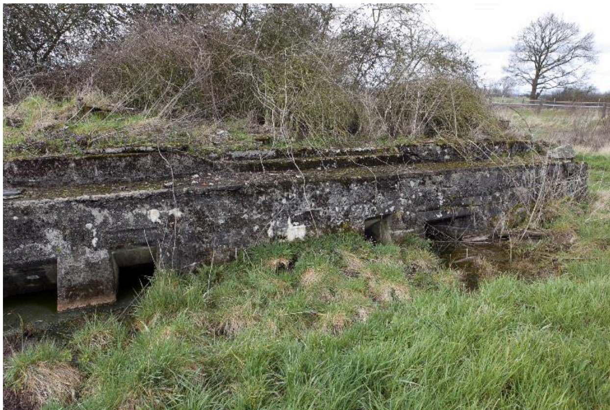
Élévation antérieure, Vers le nord.
