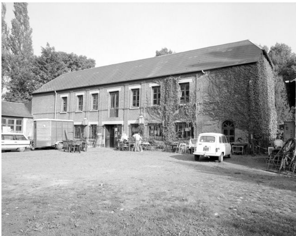
Atelier de fabrication, élévation antérieure.
