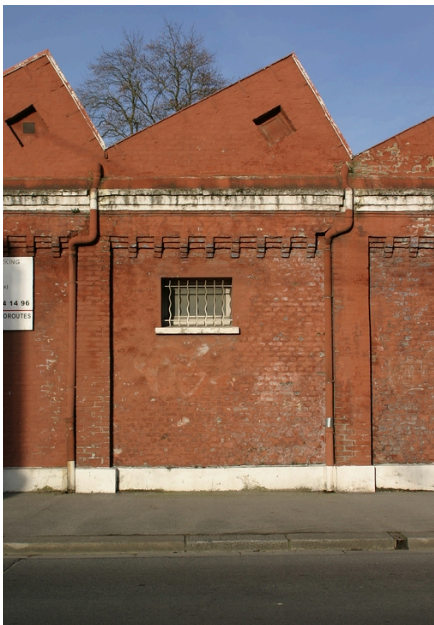
Une travée des ateliers.
