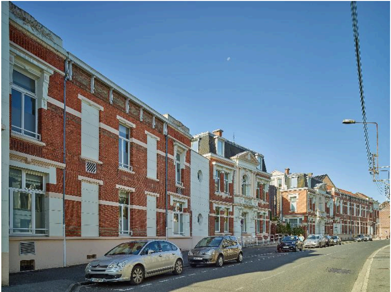
Vue générale de l'ensemble des façades de l'hôpital rue Louise de Bettignies.
