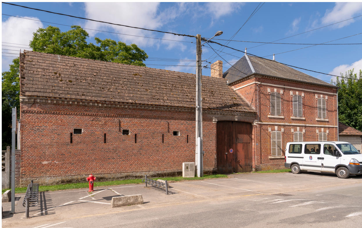
Ferme à cour construite en 1879, n°51 de la Chaussée Brunehaut, vue depuis l'est.
