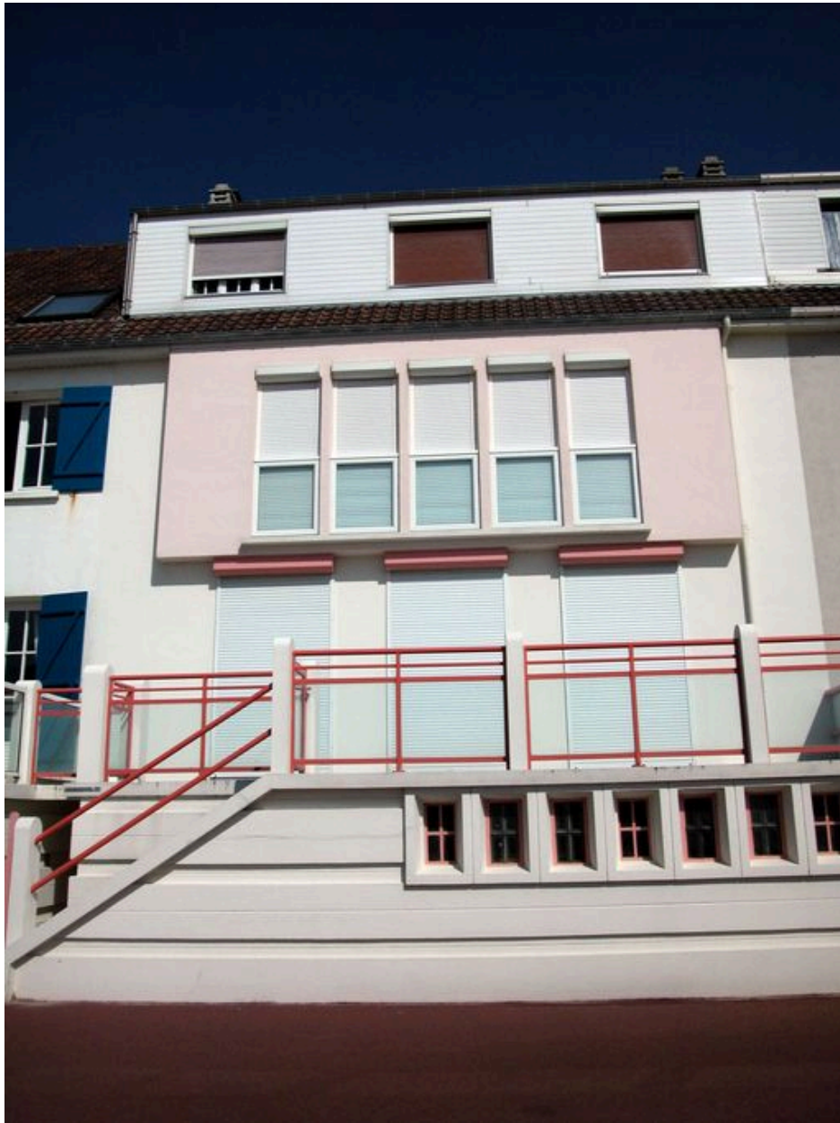
116 boulevard maritime sud (Hurlevent), façade sur mer.
