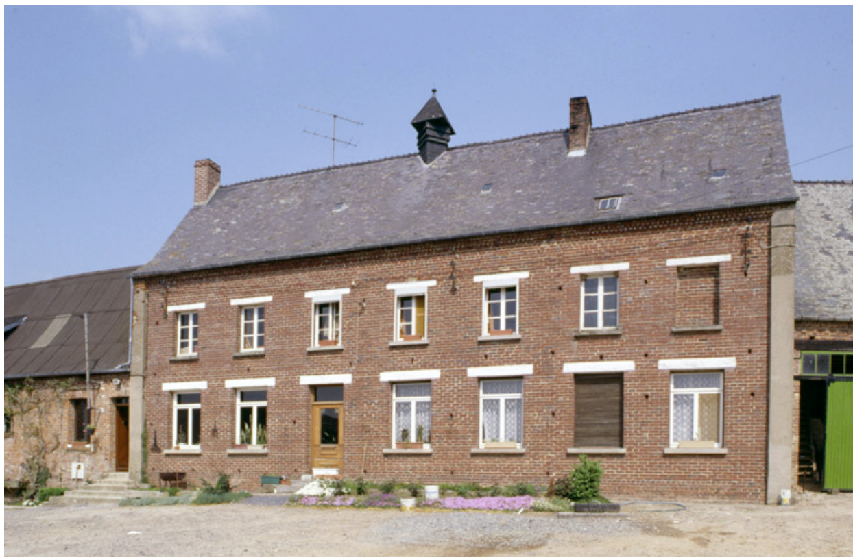
Vue générale de la façade du logis.
