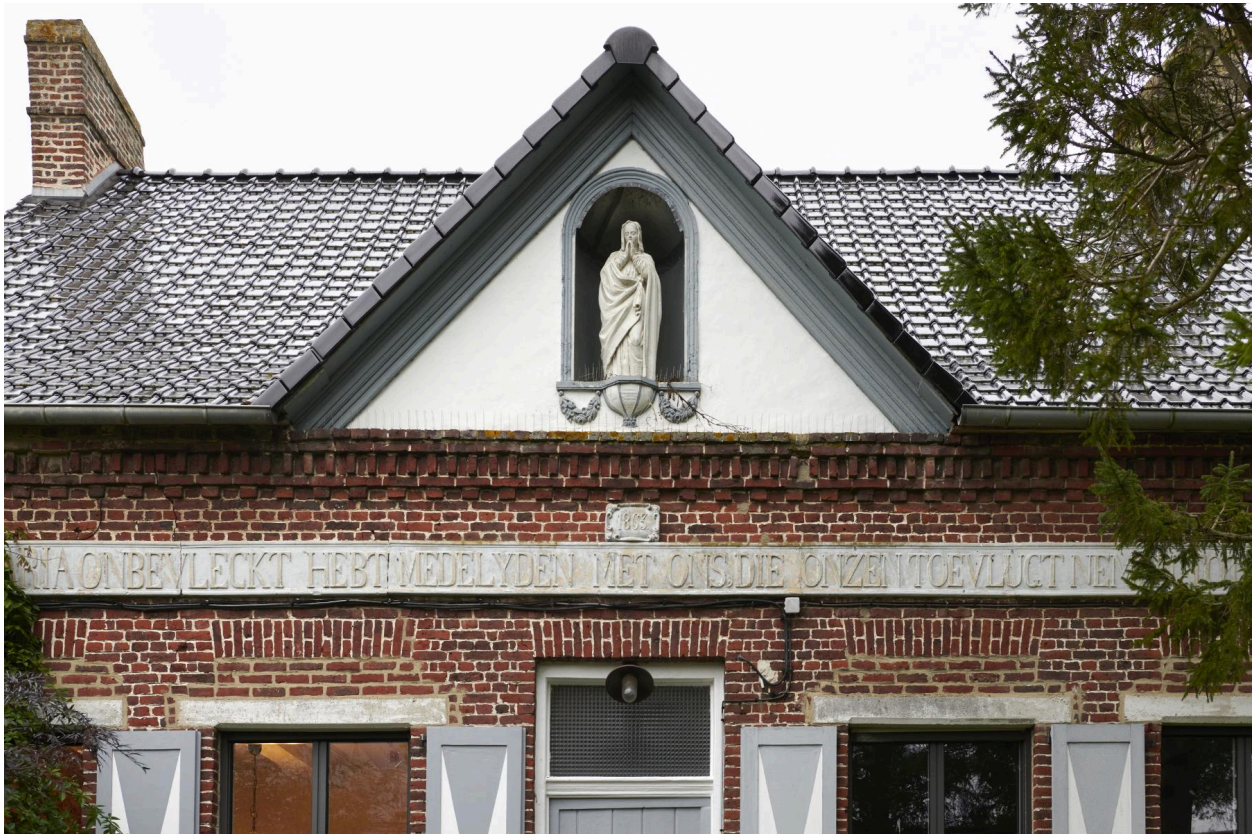
Détail de la façade.
