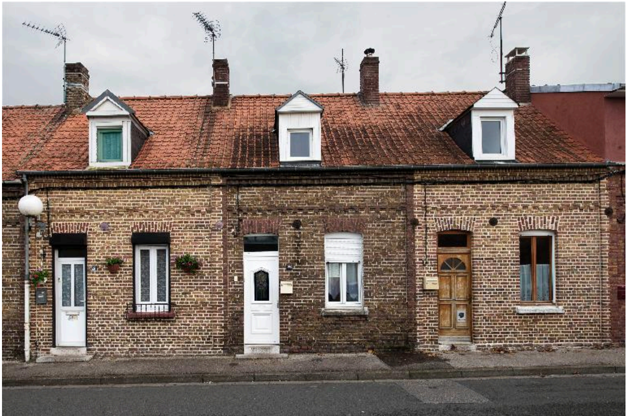
Façade sur rue de trois logements de la cité Saint-Gaston.
