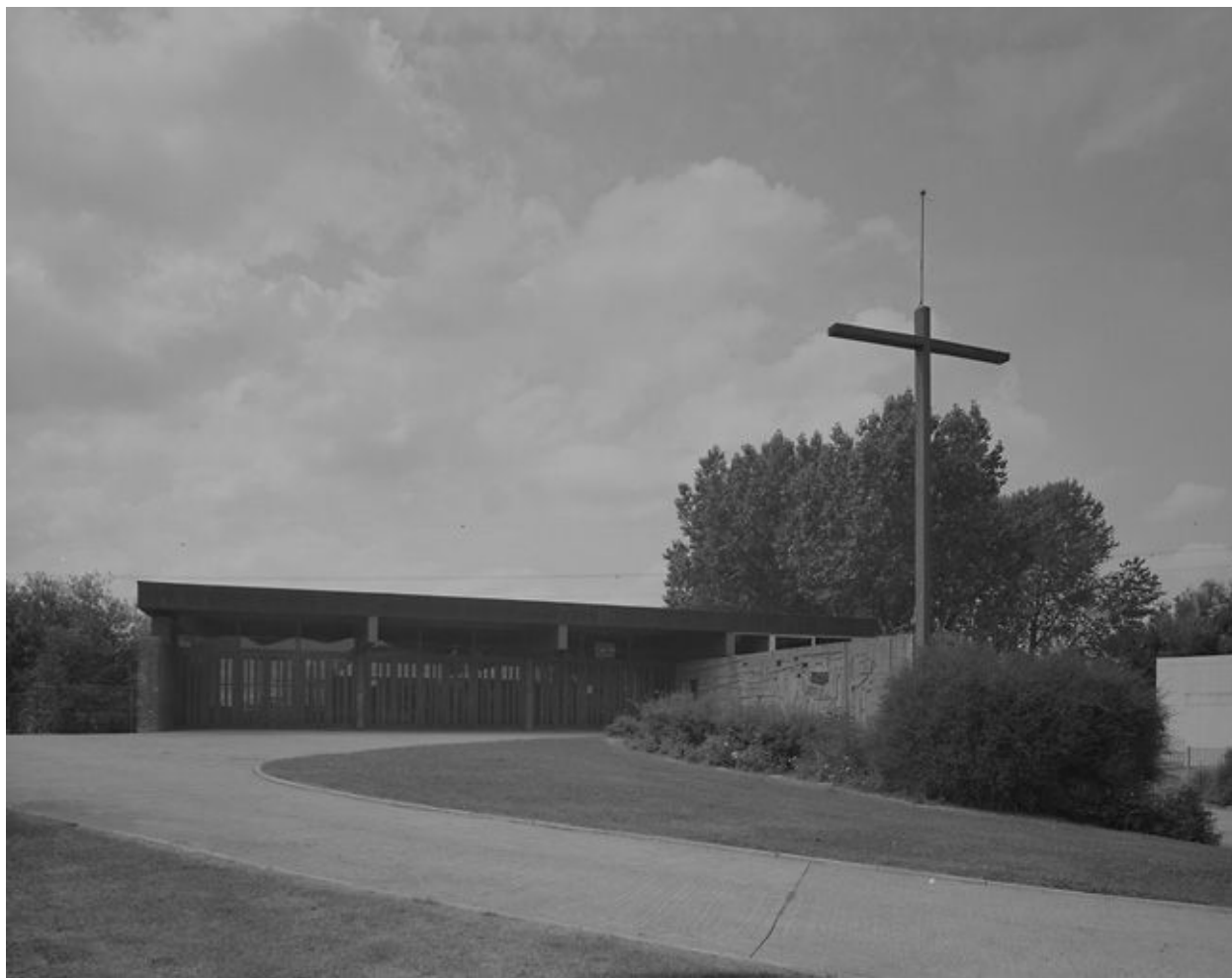
Vue de la façade est.
