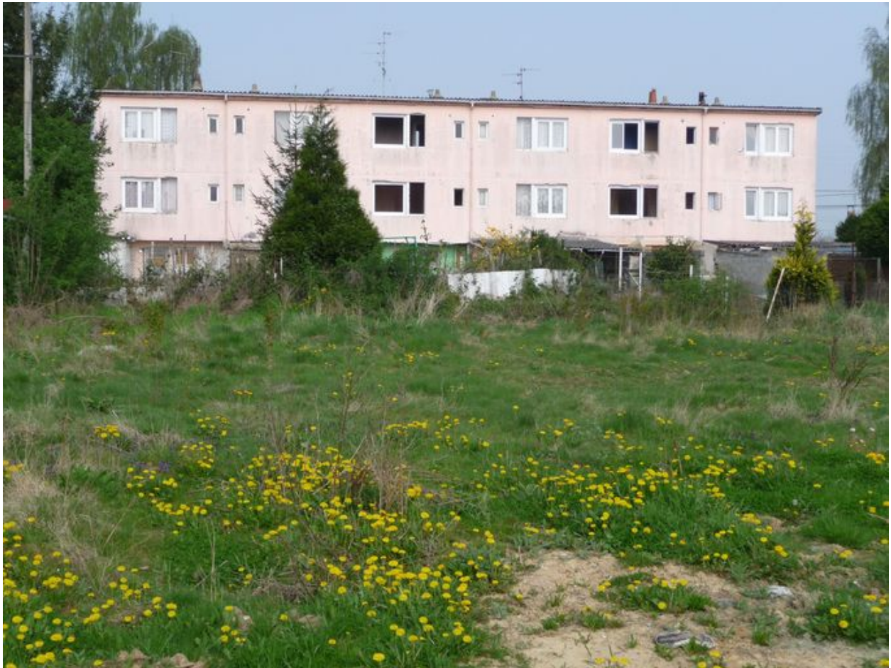
Groupe de six logements. Vue postérieure, côté jardin.
