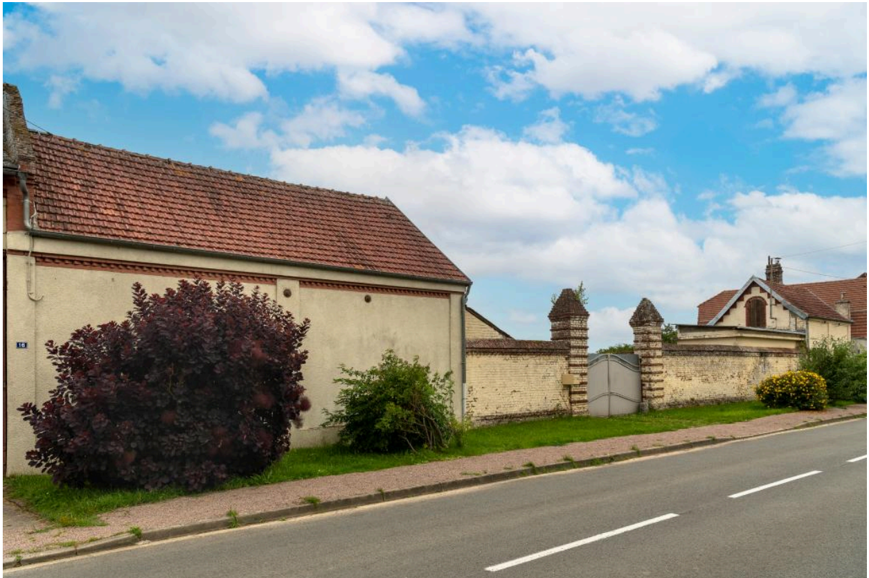
Entrée et anciens bâtiments de l'usine Lecomte, vue depuis le sud-est.
