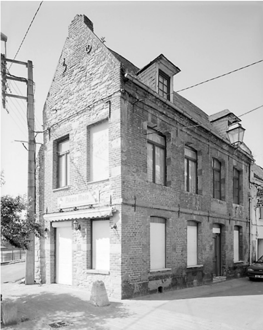
Vue générale du mur-pignon portant la date de 1507 et de la façade rue du Marais (état en 2001).
