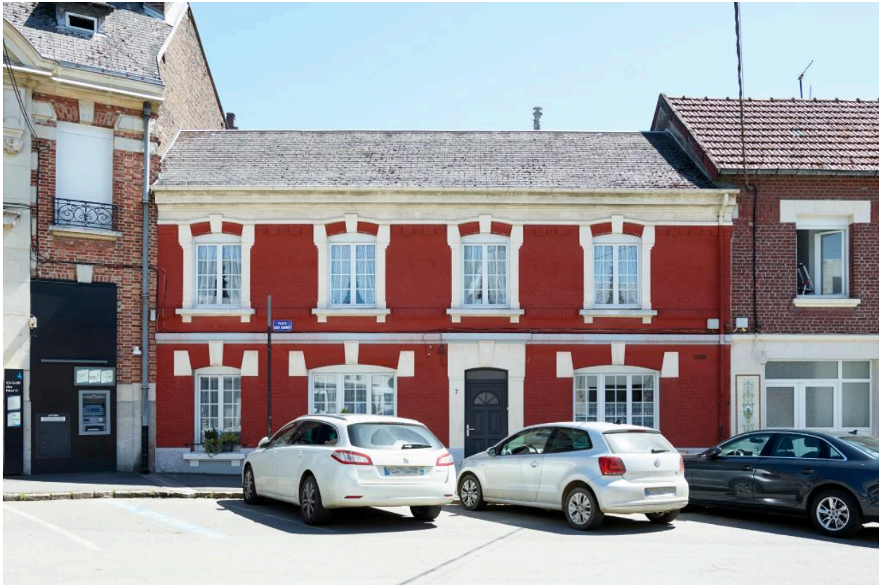
Vue générale de la maison du gardien depuis la place Sadi-Carnot.
