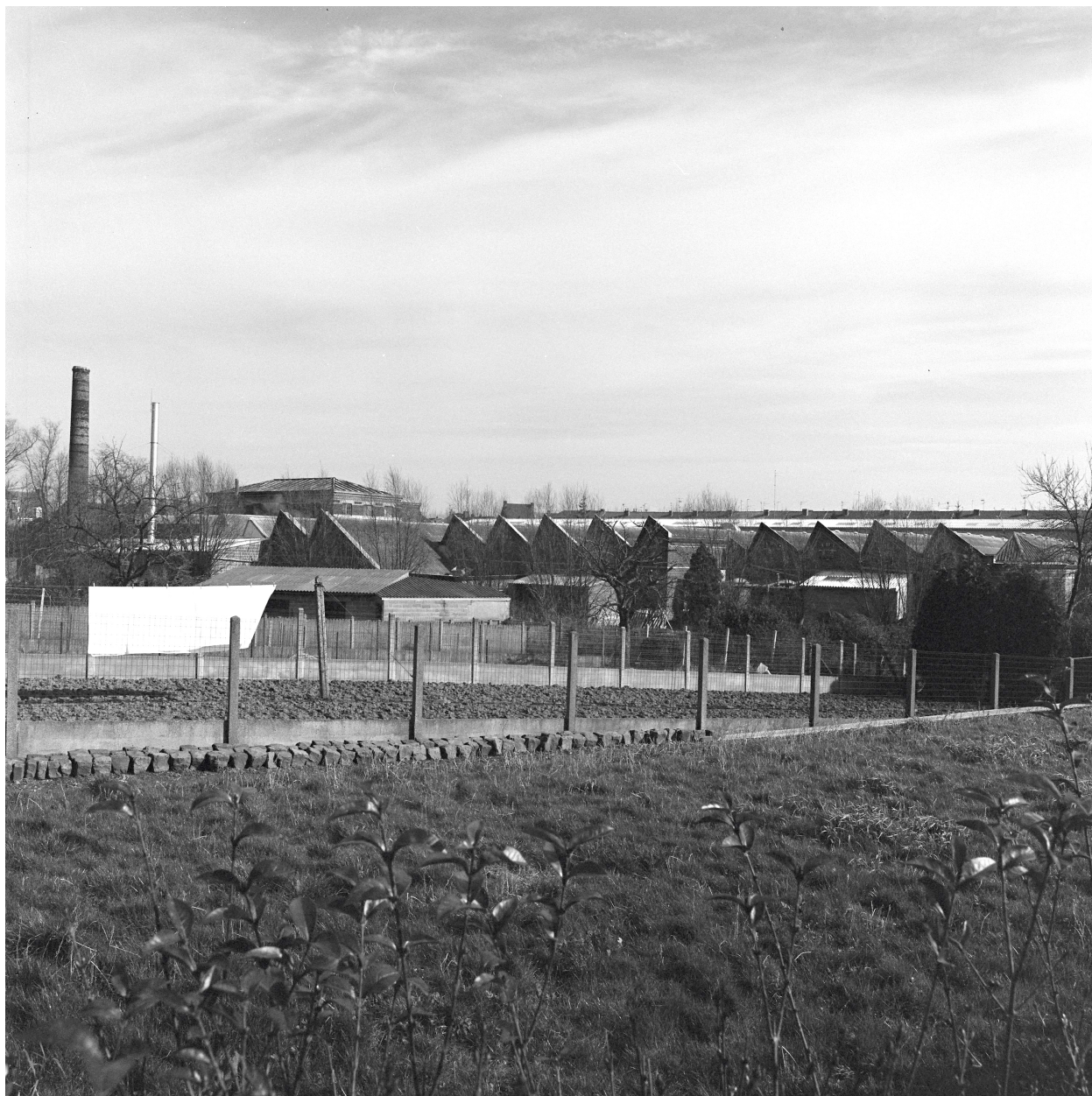
Vue générale prise vers le nord-est.
